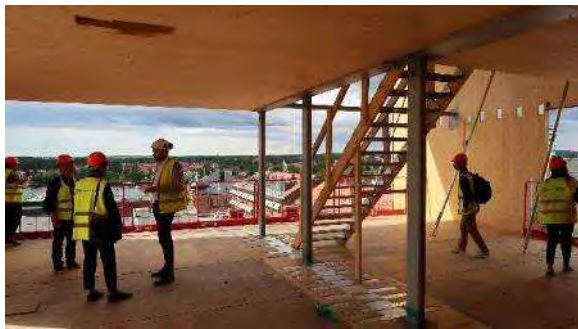
写真 3-4-2 鉄骨柱と CLT 床版
