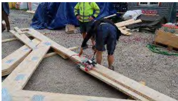
写真 4-2-5 ランバー材とギャングネル接合 による小屋組み製作。
