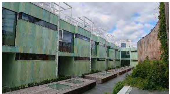
写真 3-4-7 既に入居済みの住宅部
