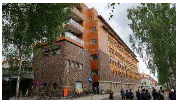
写真 3-2-1 木造 3 層増築建物
