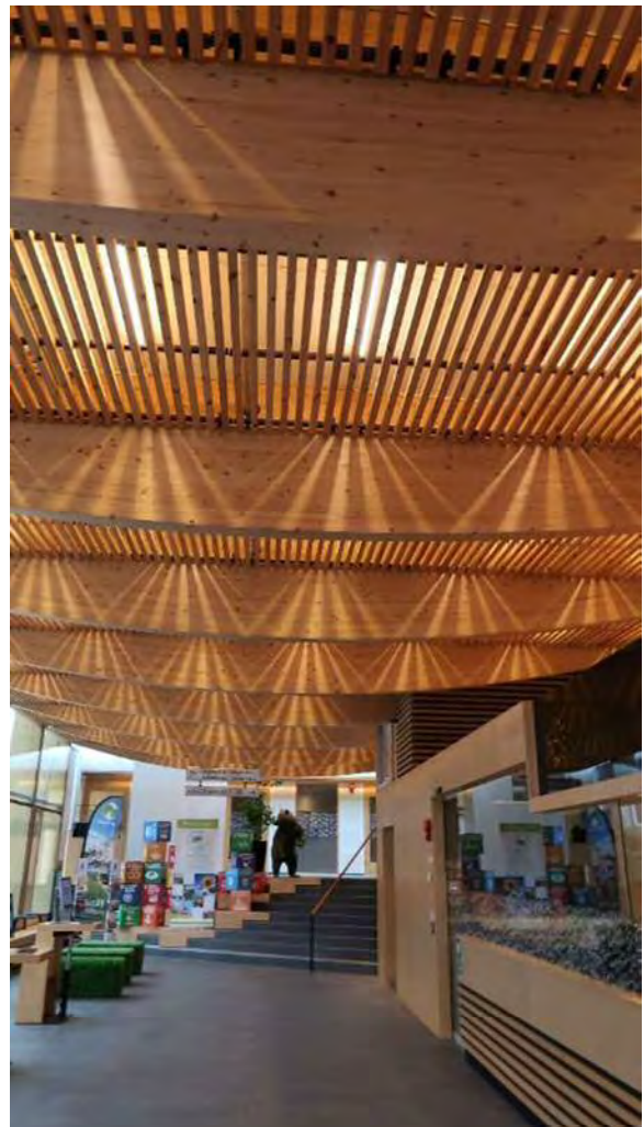
写真 4-1-3 エントランス天井グルーラム梁
