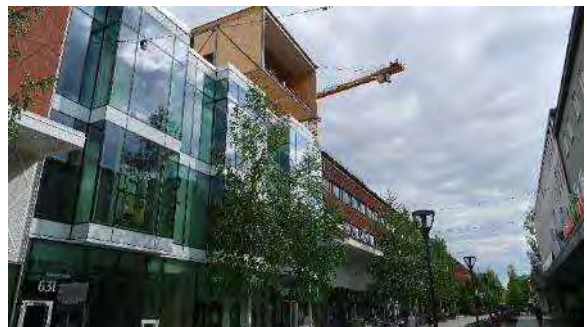
写真 3-4-6 地上階から増築部を望む
