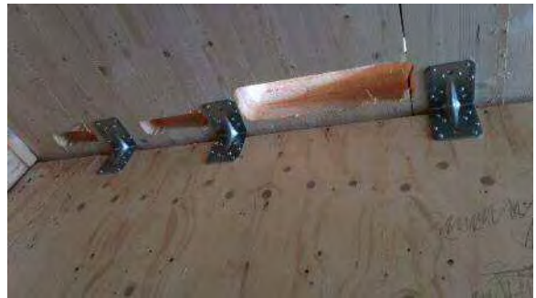
写真 4-2-7 壁床の接合金物
