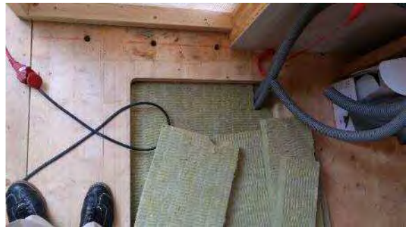
写真 3-4-8 床の防振材
