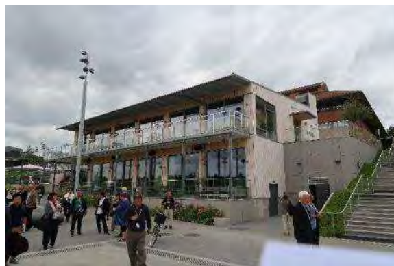
写真 2-3-1 川側から建物を見る
