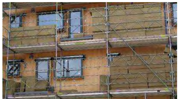
写真 4-2-9 外断熱施工、 \approx 200\text{m/m} 、木質 スウェーデンの建築物計画では室内の消費エ ネルギーの数値目標がある、外壁の断熱仕様
