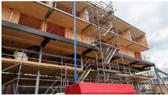
写真 3-4-1 鉄骨+CLT のハイブリット工法
