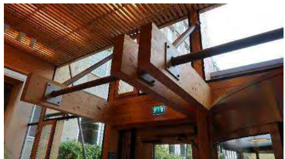
写真 4-1-4 エントランスドア上部
