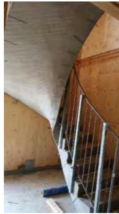
写真 4-2-6 RC製PC階段、急勾配過ぎる!
