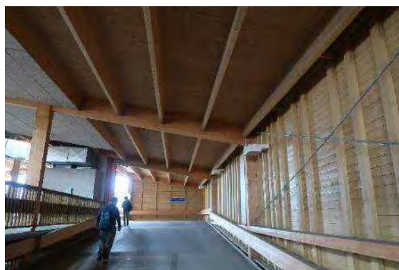
写真 2-4-3 駐車場の車路
