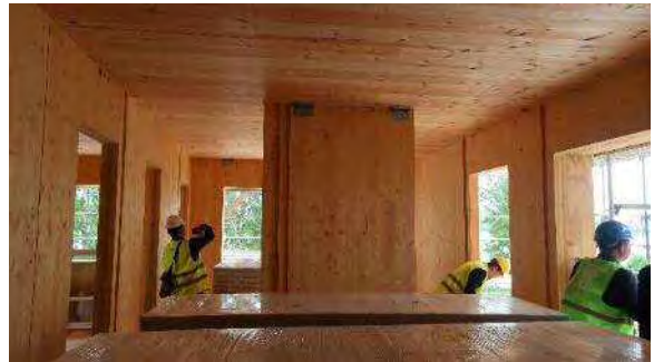
写真 4-2-8 躯体仕上がり、美しい EUのCLTの地肌は日本の杉と比較し色む らがなく仕上げ材としても使用されている。 樹種はスプルース 60%。その他、パイン 6%、 ブナ 10%等。
