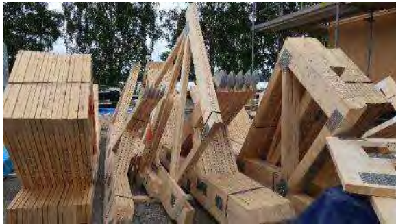
写真 4-2-4 ギャングネル使用屋根トラス
