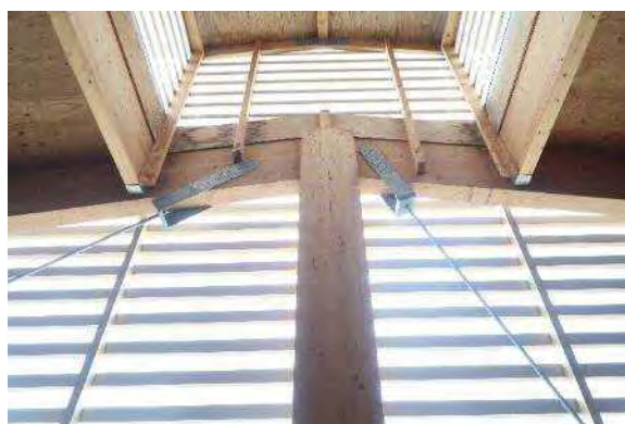
写真 2-4-4 駐車場屋根換気部
