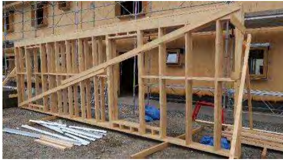
写真 4-2-3 現場での戸塚壁パネル作成 千鳥にスタッドを組んでいるのがわかる。
