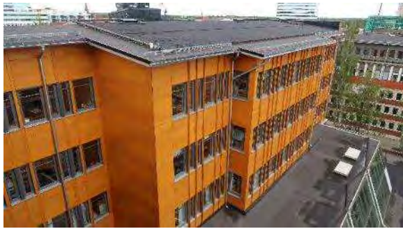
写真 3-2-6 3階増築部分、外壁コンパネ塗装 屋根断熱材 400 mm。工期は一層 2 週間、増築部全て 4 か月半で完了。
