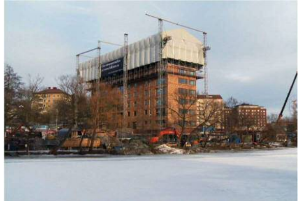
写真 1-2-8 folkhem hp テント式施工法
