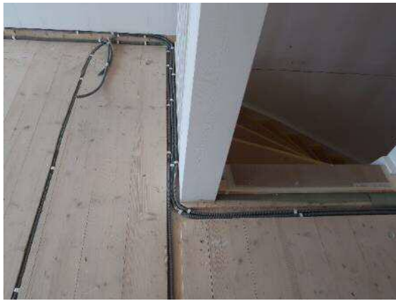
写真 1-1-4 床電気配線は溝埋め込み型
