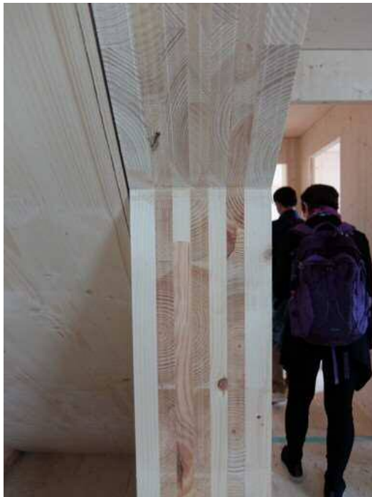
写真 1-1-10 室内壁 CLT 7 プライ
