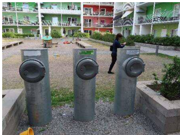
写真 0-2 破棄物自動収集投入口
