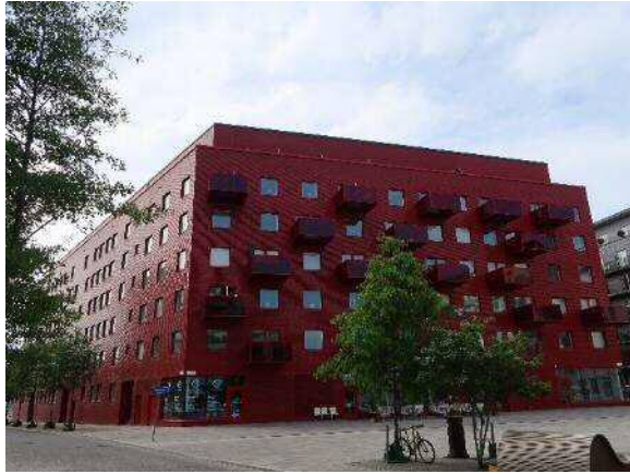
写真 0-2-7 同地区に建つRC集合住宅
