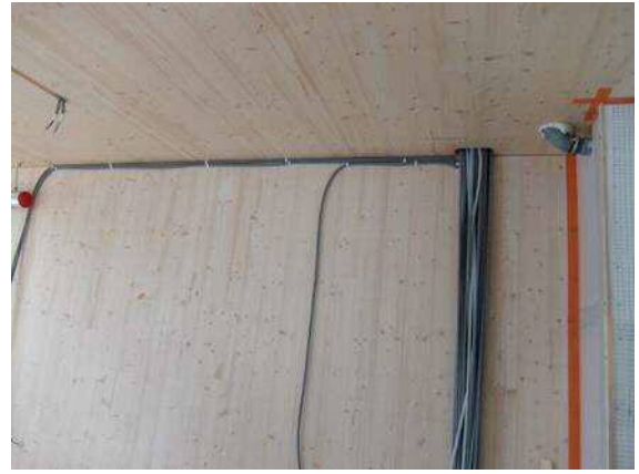
写真 1-1-6 壁電気配線
