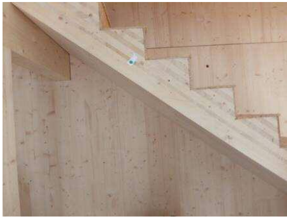
写真 1-1-9 住戸内部階段部 CLT、削りだし
