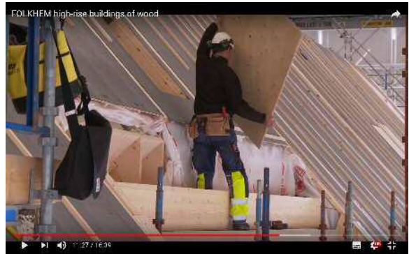
写真 1-2-7 Folkhem hp 屋根工事
