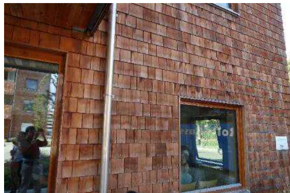
写真 1-2-9 シダーシングルの外壁
