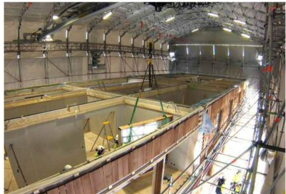
写真 1-2-9 テント内部 風・雨・雪の影響を受けず、短工期に貢献。
