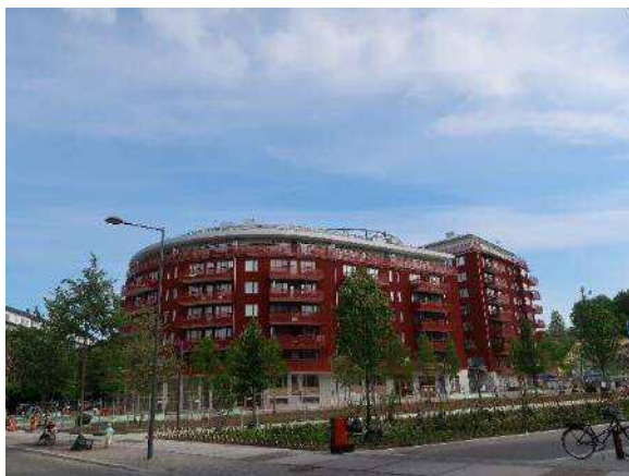
写真 0-2-9 同地区に建つRC集合住宅
