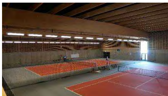
写真 4-3-3 最大梁せい3mの梁
