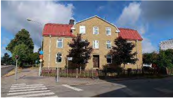
写真 小屋裏3階
