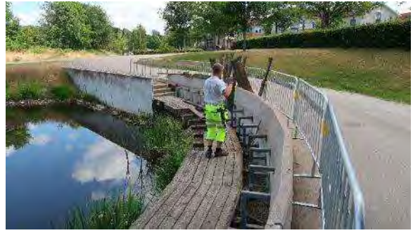
写真 5-2-15 研究施設前の池でデッキ補修
