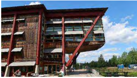
写真 5-2-10 リンネ大学研究施設
