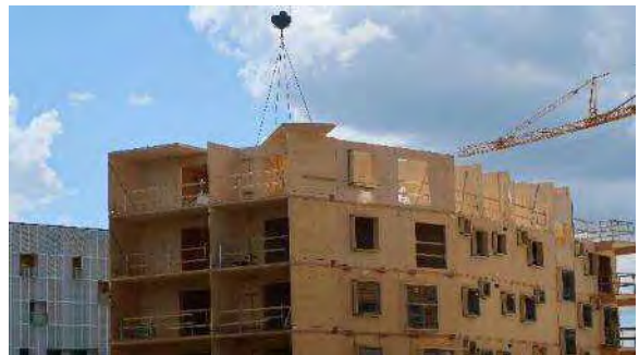
写真 5-2-7 パネル組で躯体建設中
