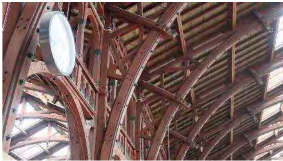
写真 駅舎も木造
