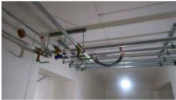
写真 4-1-7 内部、天井設備配管
