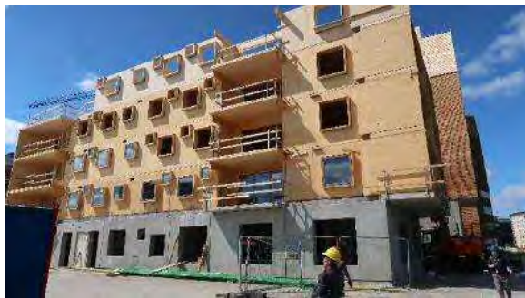
写真 4-5-3 躯体外観 美しい 下部層の外壁色が濃いのは雨風の影響で変色
