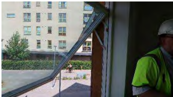
写真 4-1-9 木製サッシと空気層厚いPG
