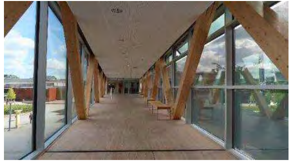
写真 5-1-14 渡り廊下と集成材筋交い
