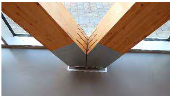
写真 5-1-12 集成材料材と金物
