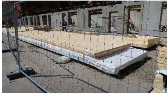
写真 4-5-6 サイトのCLT版置き場、 ここからクレーンで立て込む。1.5m×8.0mほどのCLT版。
