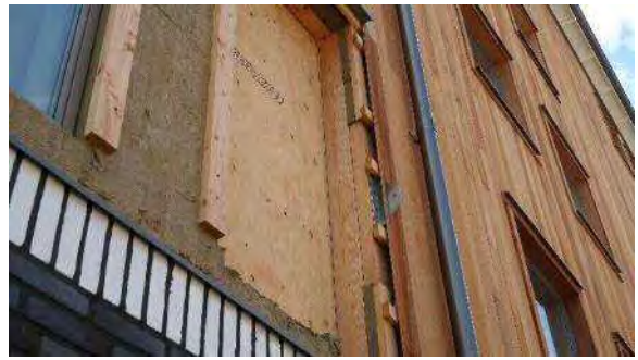
写真 4-1-4 建物外観、外壁の納まり
