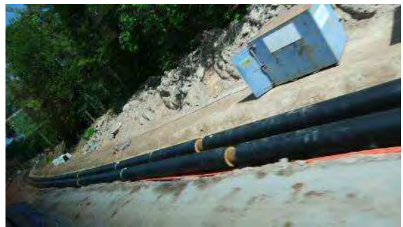
路肩に埋設中の地域熱供給用パイプ
