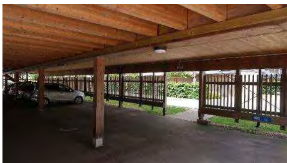
写真 5-2-14 木造駐車場内部
