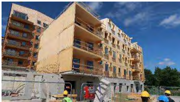
写真 4-5-4 躯体外観 1階は小学校
