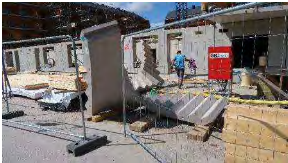
写真 4-5-5 RCのPC階段、勾配が急だ 室内耐火施策は防火塗料とスプリンクラー採用。組み合わせは所轄消防署と協議をして決定。
