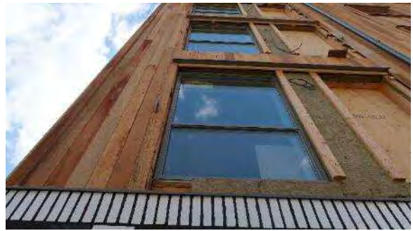
写真 4-1-5 建物外観、断熱材、仕上げ材 外壁のCLT外側には防湿シートは無し、水にオープンな仕上げだという？
