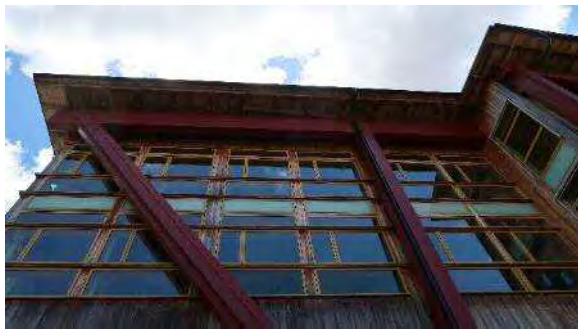
写真 5-2-12 グルーラムが部屋を吊る
