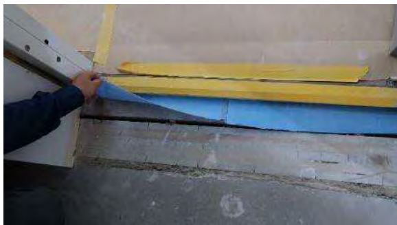
写真 4-1-10 CLT が二重壁を構成
