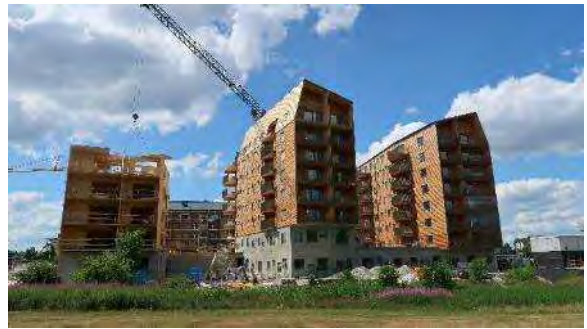
写真 5-2-5 建設中の CLT 集合住宅
