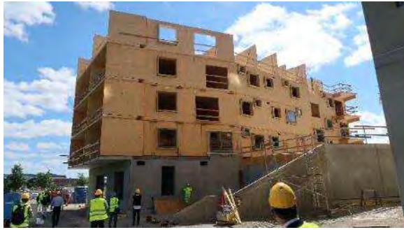
写真 4-5-2 外観 躯体組中 大型クレーンで 10mほどのCLTを吊り上げ組み立て。躯体工事は相当早い。
